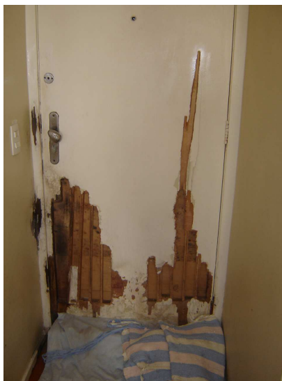
Figura 02: Destruição de objetos (porta) causada por animal com ansiedade de separação.
