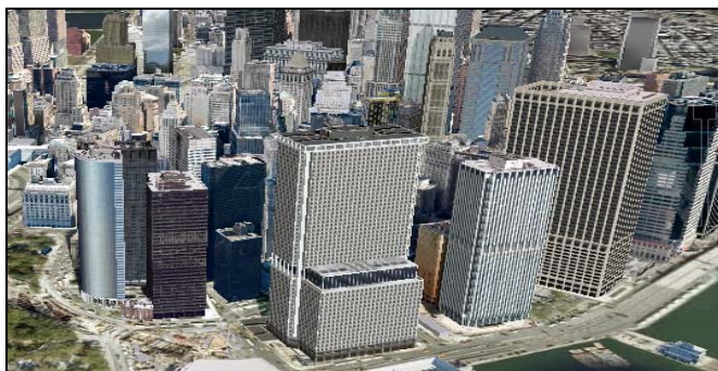
Figura 1 – Edificações representadas em 3D pelo Google Earth da cidade de Nova York.
