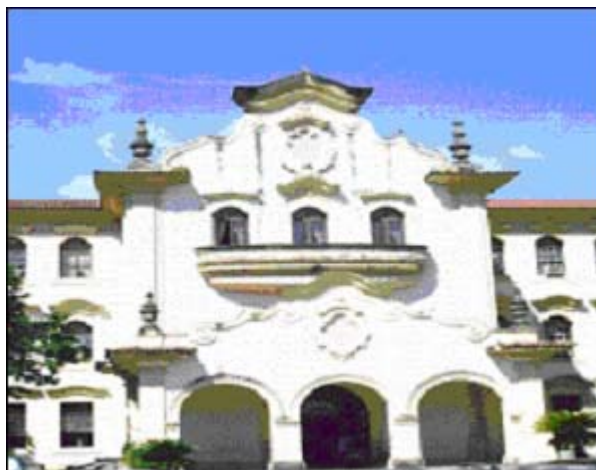
Figura 2. Edificação com diferentes alturas..
