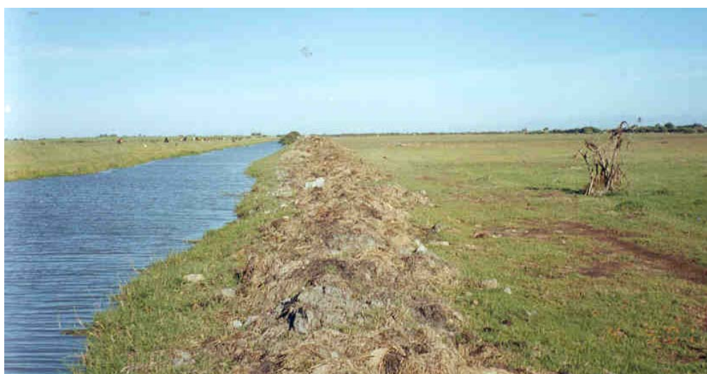
Figura 3. Canal do Sossego - córrego retificado que funciona como dreno.
