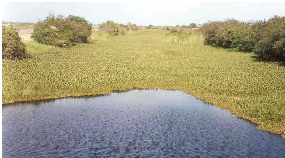
Figura 4. Canal do Pau Funcho - córrego retificado que funciona como dreno.
