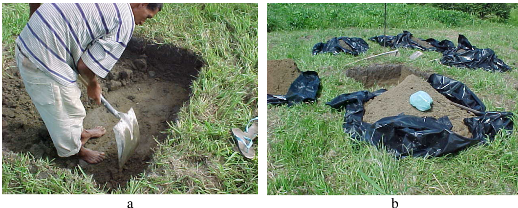
Figura 8 – Escavação do terreno para receber a caixa lisimétrica (a) e separação do solo por camadas (b).
