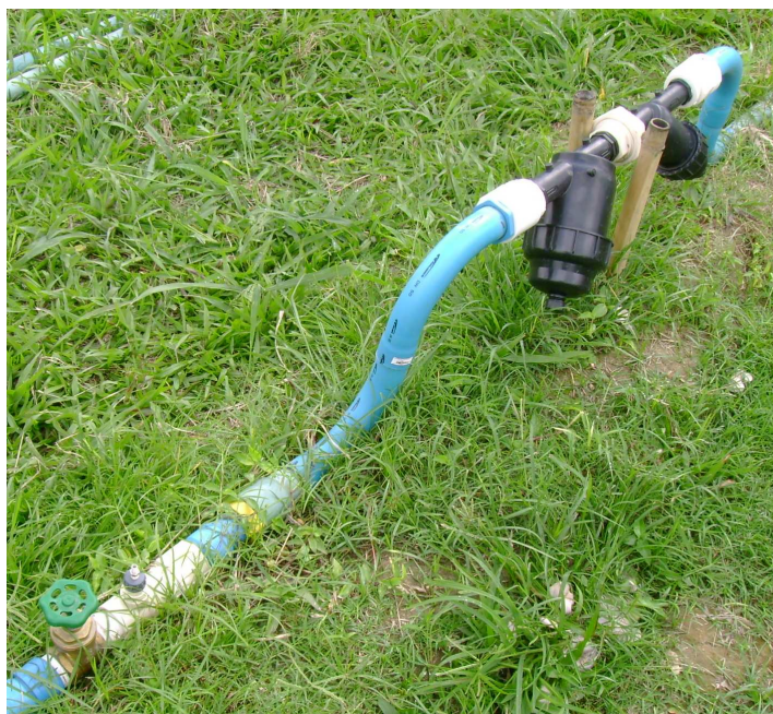
Figura 2. Cultivo orgânico da beterraba ( Beta vulgaris ‘Early Wonder Tall Top’): registro de gaveta e válvula Shradler seguidos por conjunto de filtros (filtro de disco com 125 mesh e filtro de tela de 200 mesh) no sistema irrigado (Seropédica – RJ, 2008).
